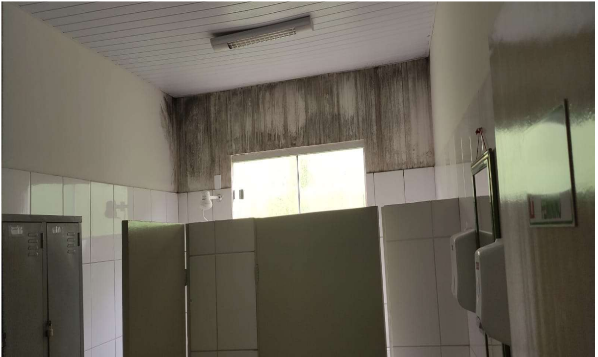
IMAGEM 3 (PAREDE DO BANHEIRO)
